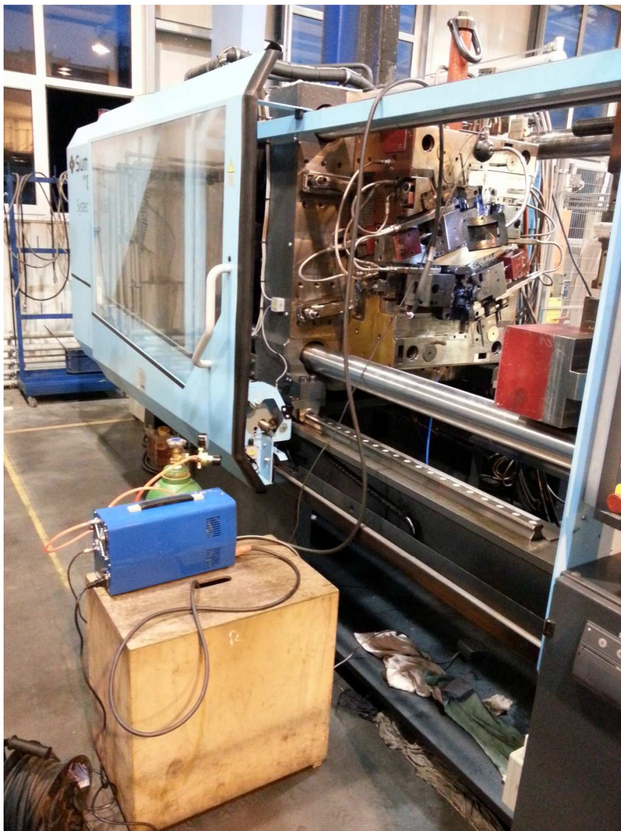
Oprava vyhazovačů formy pomocí TTW metody přímo na lisu během odstávky.
